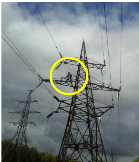
Рисунок 6.42 – Установка закоротки на ЛЭП с помощью переносного заземления.
