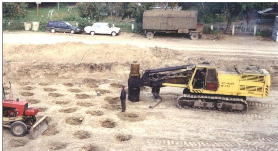
Рис. 3. Агрегат для глубинного трамбования грунта
